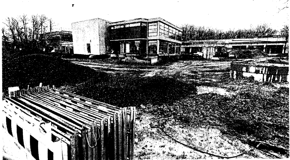
Baustelle Bürgerhaus Lerchenberg: In Sachen künftige Gastronomie gab es nun keine guten Nachrichten im Ortsbeirat. Foto: Tim Würz (Archiv)
